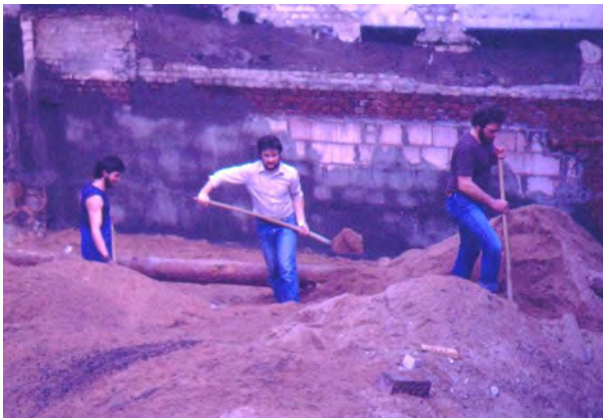
Aushub der Baugrube per Hand (von li. nach re.) mit Uwe Löhner, Udo Schmidt und Uwe Polifke
