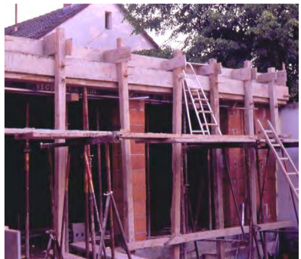
Der fortgeschrittene Rohbau
